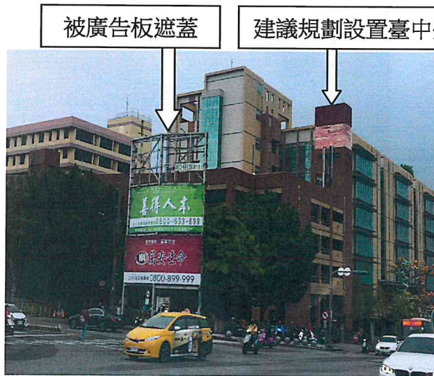
圖二十 臺中榮民總醫院急診大樓停車場
