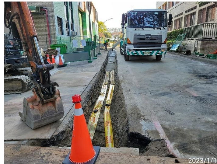
高壓管線PC澆置
