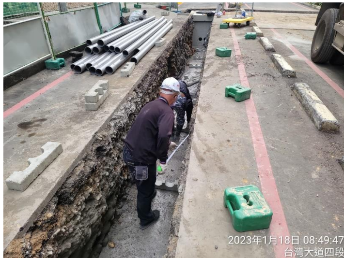
高壓管線配管
