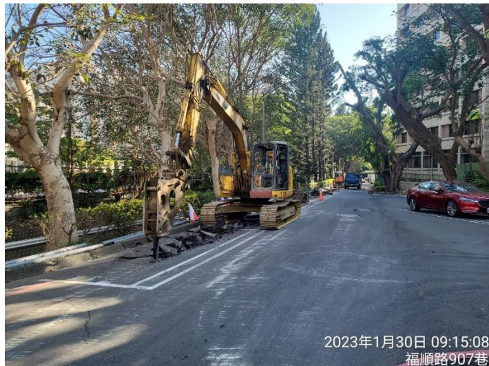
高壓管線AC刨除
