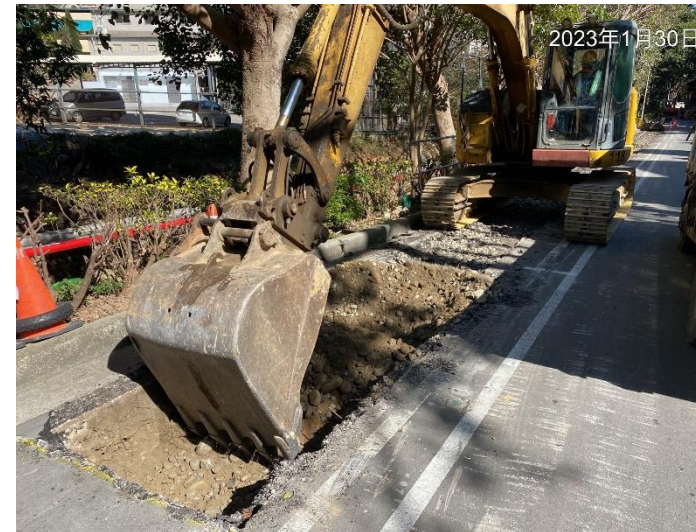
高壓管路管溝挖掘
