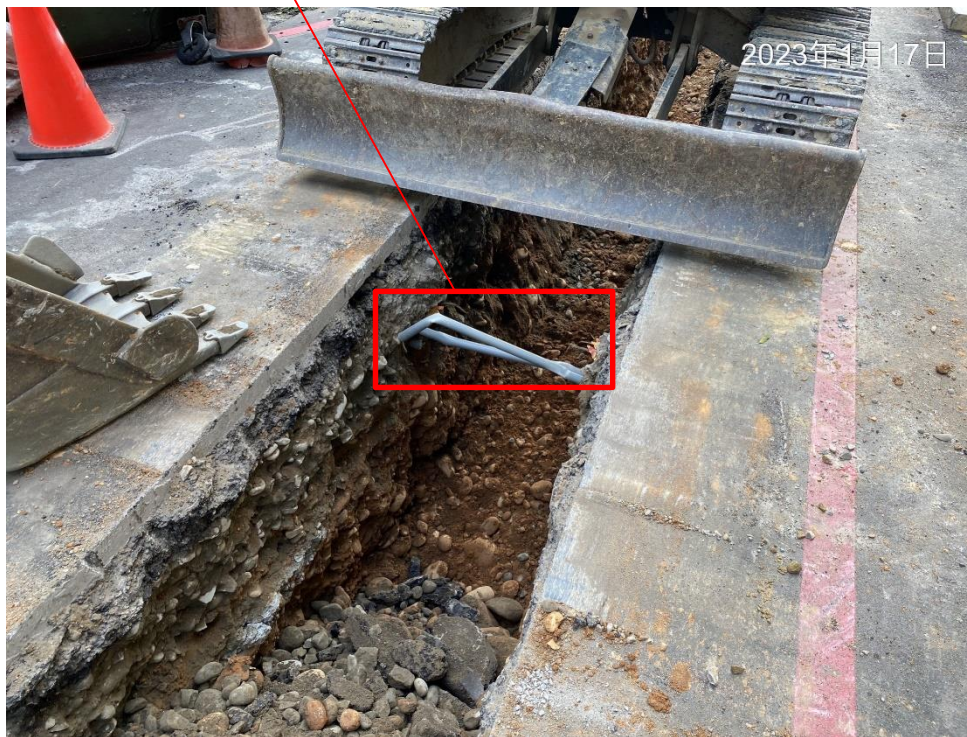
手孔#4及#5中間管溝既有管線
