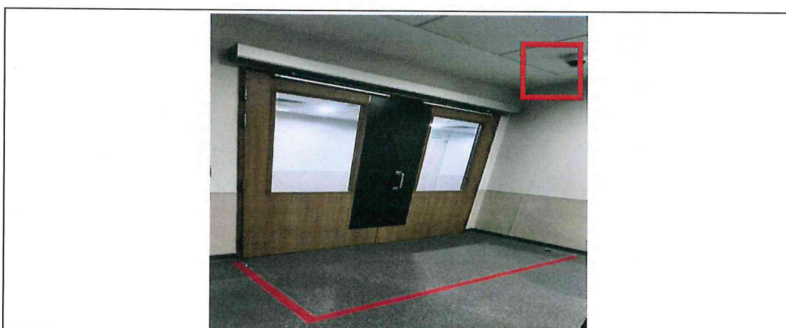
圖 17. 每扇門上方皆有監視器，自動開門，減少接觸門把，造成手部污染
