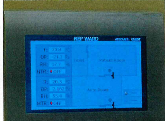
圖 11. 負壓系統於電子面板即時監控
