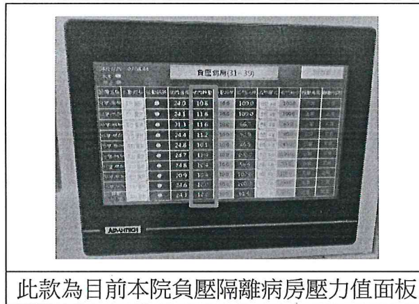
圖三十七、負壓隔離病房壓力值自動偵測及通報
