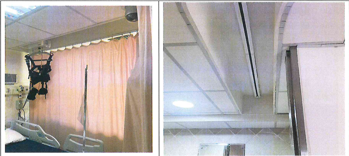
圖 32 72 病房 121 床的癲癇病人滑軌設地延伸至廁所
