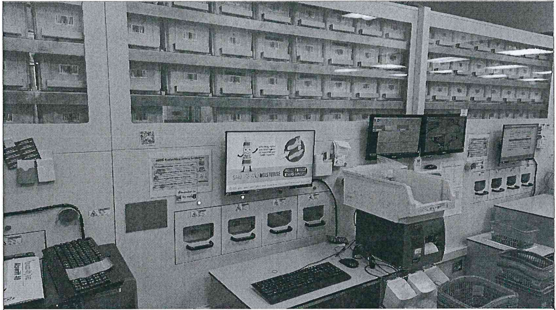
圖 7. ASRS 藥品儲存遞送系統
