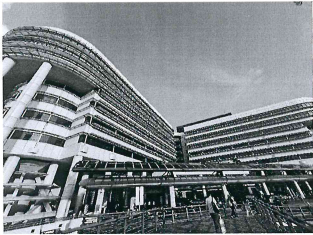
KKH 外觀，左為婦產科大樓，右為兒科大樓
